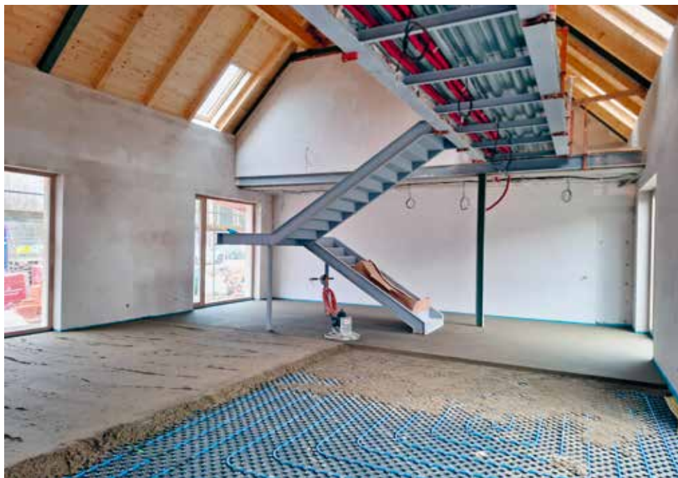
Výstavba Návštěvníkého a vzdělávacího centra Trocnov.
