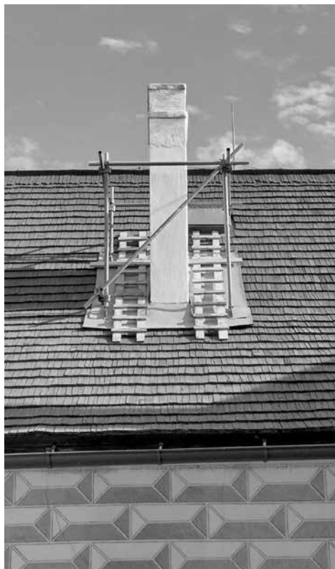
Oprava a obílení nefunkčního komínu nad východní částí nádvoří.
