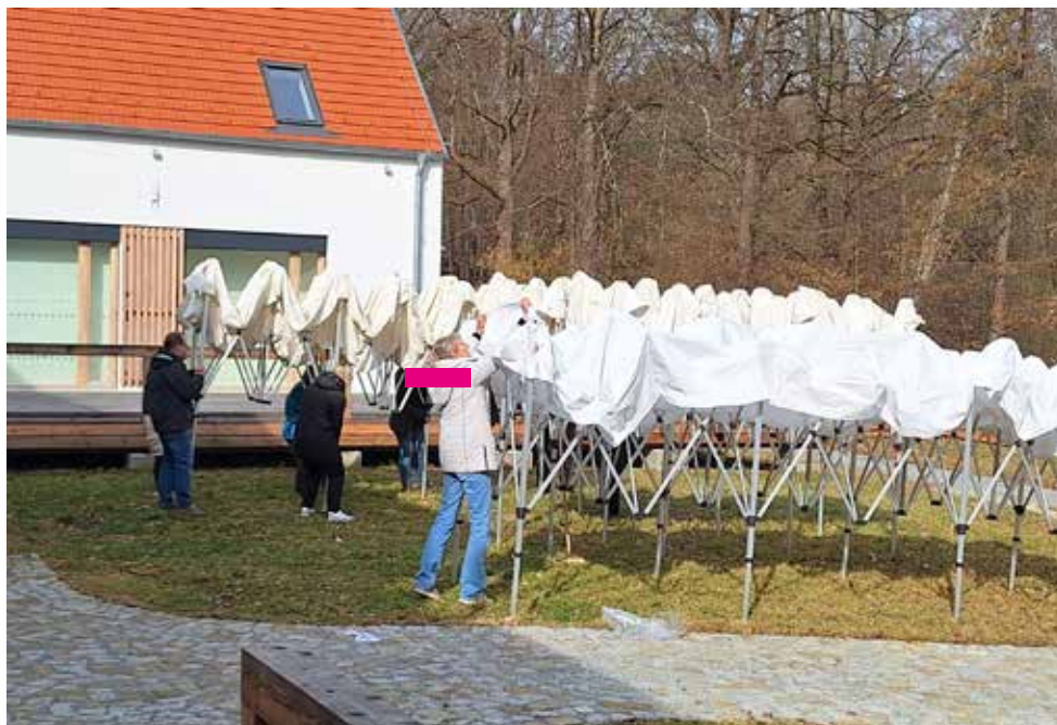
Stavba zastřešení hlediště
