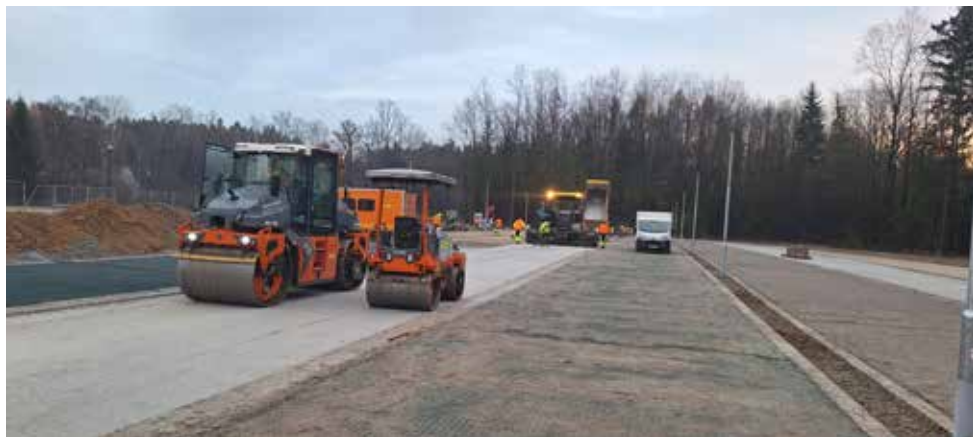
Stavba parkoviště firmou COLAS s.r.o. (kapacita 243 parkovacích míst)
